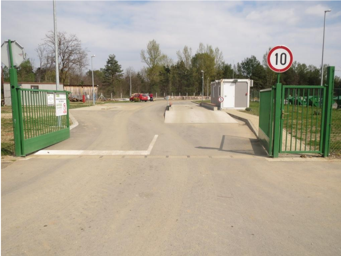
Slika 6. Ulaz na parcelu odlagališta otpada i mosna vaga
